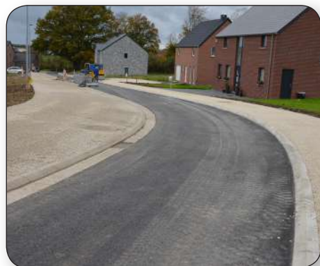
La construction de plusieurs habitations étant terminée, le Chemin de messes a été remis en état par le lotisseur.
