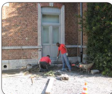
Certaines pierres étaient soit cassées, soit descelées. Une chape bien plane a été coulée sur le sol avant que les marches ne soient remplacées.
