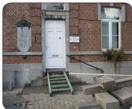
Les perrons et marches d'accès de la maison communale ont été remis en état par l'EFT 'Côté Cour' d'Amay.
