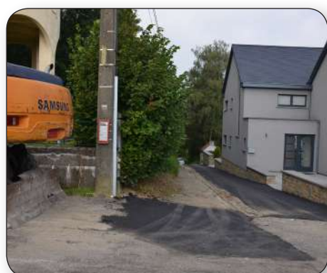
Le tronçon de voirie de la rue Malplaquaye a été réparé par l'entreprise Frères.
