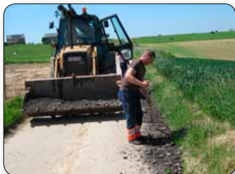
Après avoir raclé les accotements des routes communales, les ouvriers continuent ce même travail le long des chemins de remembrement.
