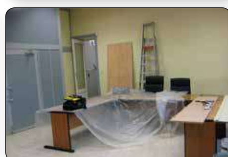
Chantier à la commune
