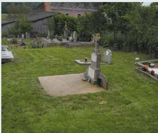
Création d'une aire de dispersion à Fraiture
