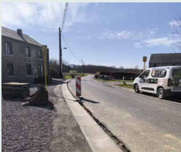
Remplacement des filets d'eau à Petit Seny
