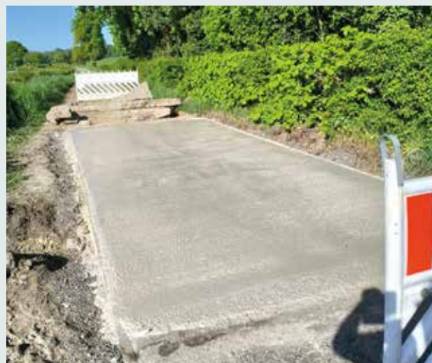
Réparation remembrement - Rue Gistrée à Seny
