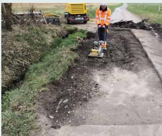
Réparation voirie - Rue de Linchet à Ramelot
