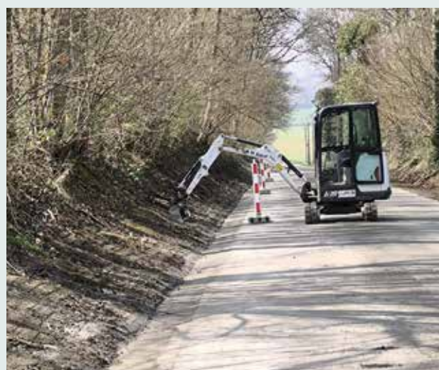
Nettoyage et renforcement des bordures - rue Gommeray à Fraiture
