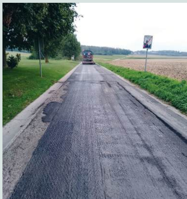
Entretien et réfection de la voirie Rue du Tilleul
