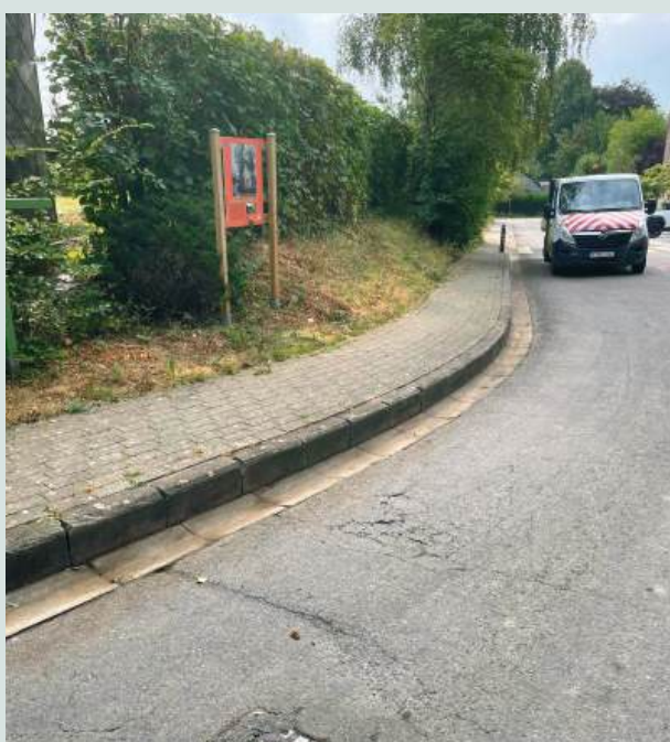
Entretien et nettoyage des filets d'eau
